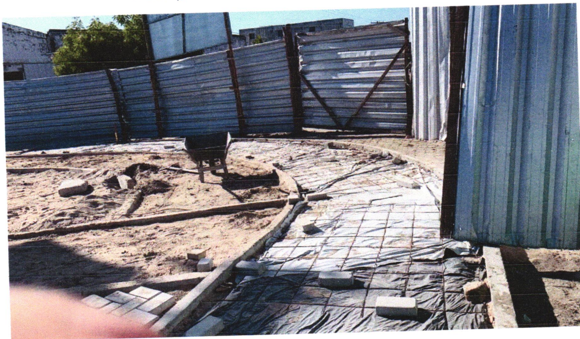
Foto 04 - APLICAÇÃO DE LONA PLÁSTICA PARA EXECUÇÃO DE PAVIMENTOS DE CONCRETO. AF_04/2022
