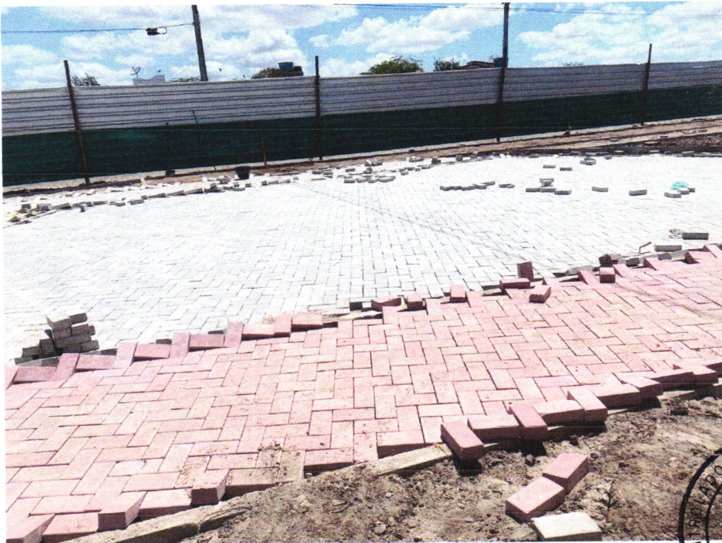
Foto 12 - EXECUÇÃO DE PASSEIO EM PISO INTERTRAVADO, COM BLOCO RETANGULAR COR NATURAL DE 20 X 10 CM, ESPESSURA 6 CM. AF_12/2015
