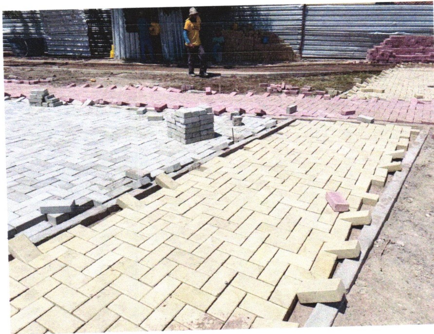
Foto 09- EXECUÇÃO DE PASSEIO EM PISO INTERTRAVADO, COM BLOCO RETANGULAR COLORIDO DE 20 X 10 CM, ESPESSURA 6 CM. AF_12/2015
