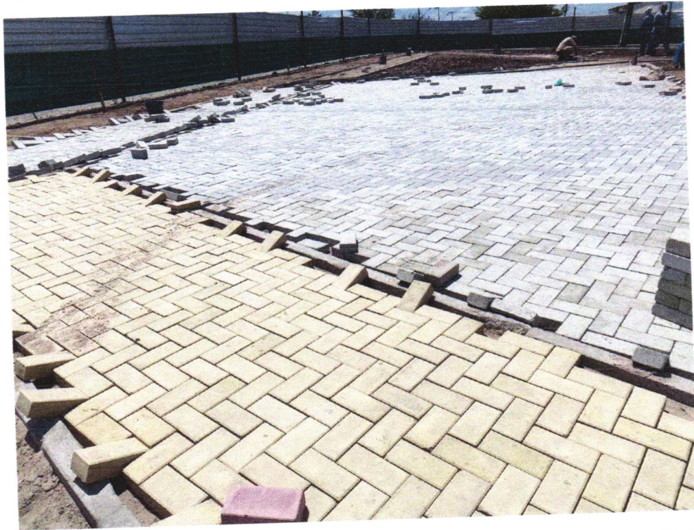
Foto 13 - EXECUÇÃO DE PASSEIO EM PISO INTERTRAVADO, COM BLOCO RETANGULAR COR NATURAL DE 20 X 10 CM, ESPESSURA 6 CM. AF_12/2015
