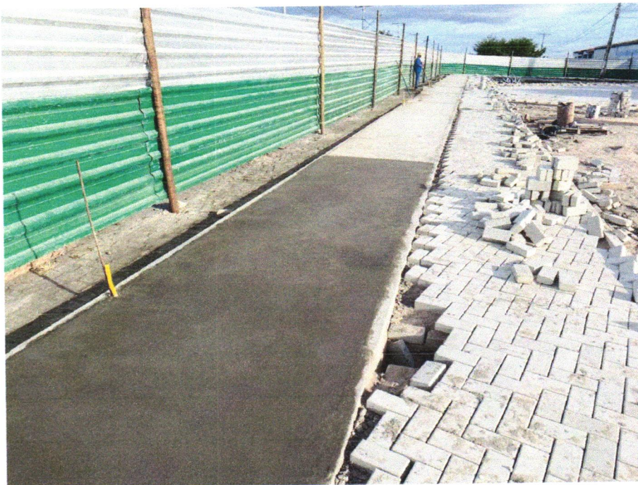
Foto 06 - EXECUÇÃO DE PASSEIO (CALÇADA) OU PISO DE CONCRETO COM CONCRETO MOLDADO IN LOCO, FEITO EM OBRA, ACABAMENTO CONVENCIONAL, ESPESSURA 6 CM, ARMADO. AF_07/2016
