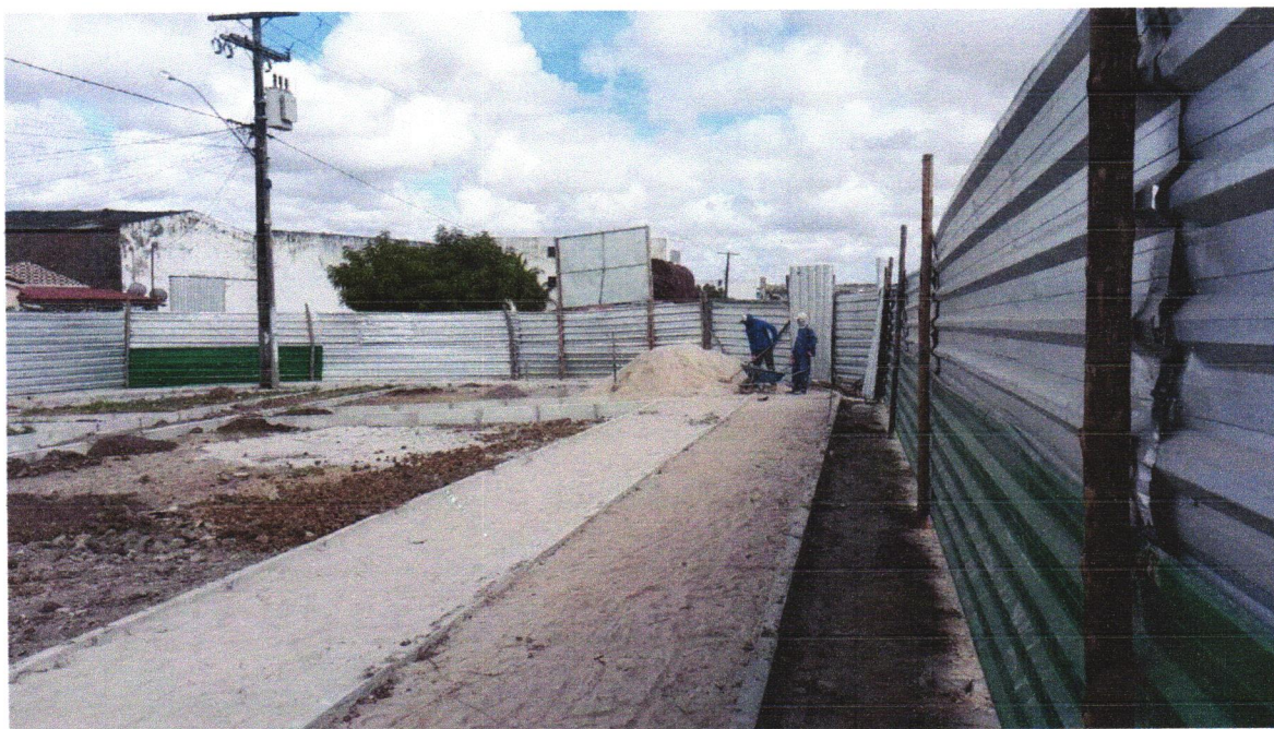
Foto 01 - ATERRO C/COMPACTAÇÃO MECÂNICA E CONTROLE, MAT. DE AQUISIÇÃO
