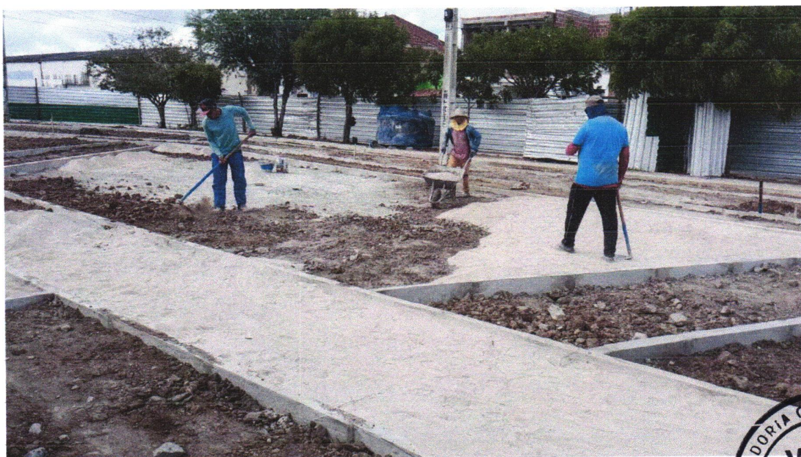
Foto 02 – ATERRO C/COMPACTAÇÃO MECÂNICA E CONTROLE, MAT. DE AQUISIÇÃO
