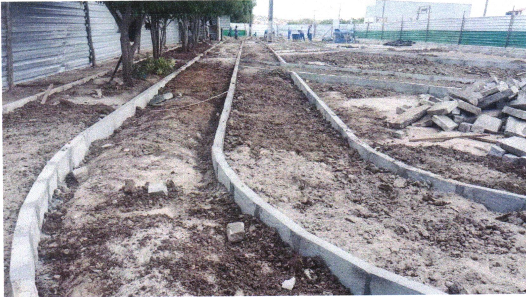
Foto 11- GUIA (MEIO-FIO) CONCRETO, MOLDADA IN LOCO EM TRECHO RETO COM EXTRUSORA, 13 CM BASE X 22 CM ALTURA. AF_06/2016
