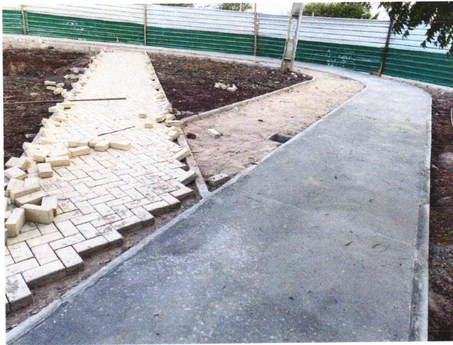
Foto 05 - EXECUÇÃO DE PASSEIO (CALÇADA) OU PISO DE CONCRETO COM CONCRETO MOLDADO IN LOCO, FEITO EM OBRA, ACABAMENTO CONVENCIONAL, ESPESSURA 6 CM, ARMADO. AF_07/2016
