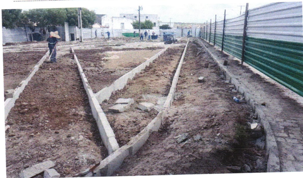
Foto 03- ASSENTAMENTO DE GUIA (MEIO-FIO) EM TRECHO RETO, CONFECCIONADA EM CONCRETO PRÉ-FABRICADO, DIMENSÕES 100X15X13X30 CM (COMPRIMENTO X BASE INFERIOR X BASE SUPERIOR X ALTURA), PARA VIAS URBANAS (USO VIÁRIO). AF_06/2016
